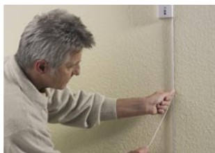
7.) Kabel im transparenten Kabelkanal fixieren.
