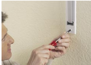
1.) Schrauben des alten Gurtwicklers lösen...
