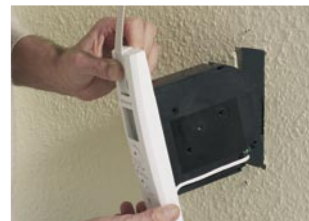
6.) Gerät in die Maueröffnung einschieben und festschrauben.
