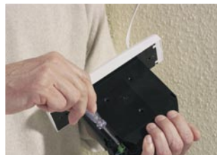
5.) Kabelkontakte am Gerät festschrauben
